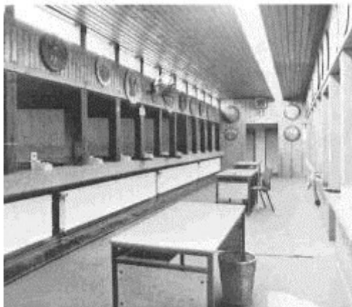
Die Luftgewehrstände vor dem Umbau der Schießanlage
